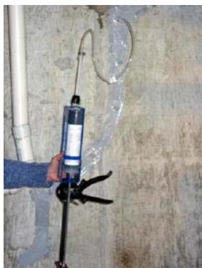
Ống bơm silicon đầu có vòi để bơm vào khe kẽ giữa tấm kính và khuôn cửa.
